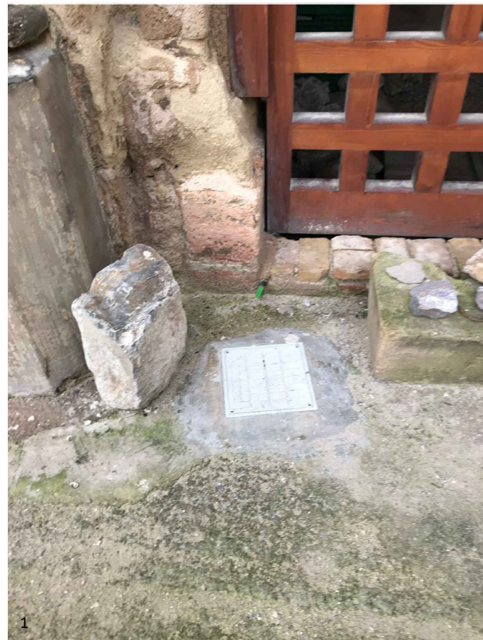
1 Cableado de distribución y caja de alimentación en la capilla de las Lágrimas.
